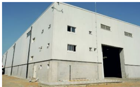
Nouveaux magasins cales, symboles de la rénovation, de la modernisation et du développement.
