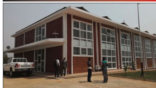
Les Ateliers Municipaux de Bertoua construits par le C2D
