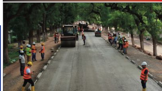
La voirie de Maroua en aménagement grâce au C2D.
