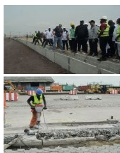
Un domaine portuaire en chantier.
