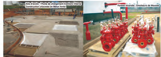
Voie d'accès / Poste de chargement Camions Citerne Construction chaussée en Béton Armé
