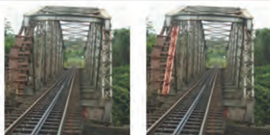
Réparation d'un pont ferroviaire sur le réseau CAMRAIL (Cameroun) / Notre Mission : Modelisation et vérification de la structure, méthode d'exécution.
