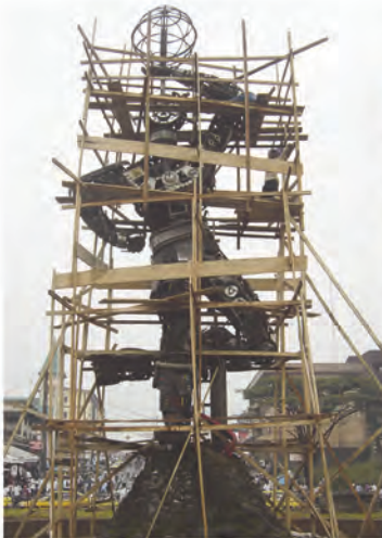
Statue de la Nouvelle Liberté au Rond point Deido / Douala Maitre d'ouvrage : doula'art (Cameroun) Artiste : Francis-Joseph Sumégné (Cameroun) Notre mission : Conception de l'ossature métallique, Etudes techniques : Structure et Fondations
